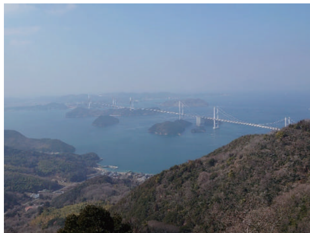
▲亀老山展望公園から望む来島海峡～来島海峡大橋～
